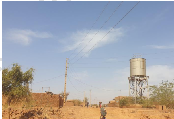
Figure 4 : Château d'eau et supports électriques impactés par la variante A
